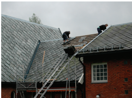
Delen av skifertaket til kapellet som måtte renoveres, ved begynnelsen av arbeidet.
