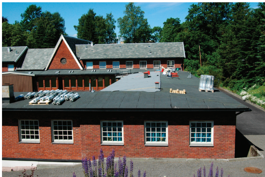
Taket ved begynnelsen av renoveringen.
