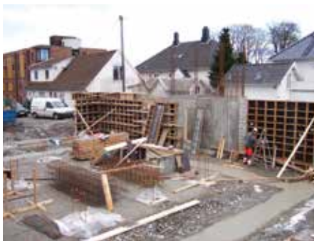
Forskalingen av det som blir grunnetasjen i kirken, er godt i gang.
