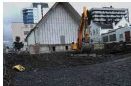
Oktober 2010. Det er klart for grunnarbeidene. Mye masse måtte fjernes.
