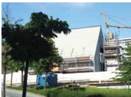
Taket er tett, men det mangler fortsatt takstein. Klokketårnet begynner å vises igjen.
