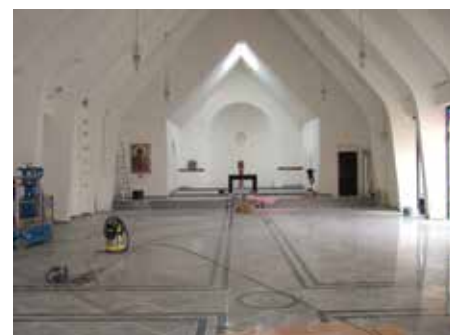
August 2012: Kirkerommet sett fra inngangen mot koret.
