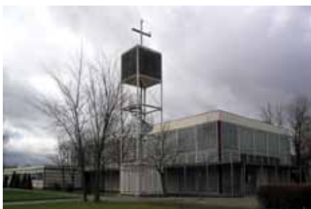
Nåværende St. Olav kirke er i dårlig stand og må rives.
