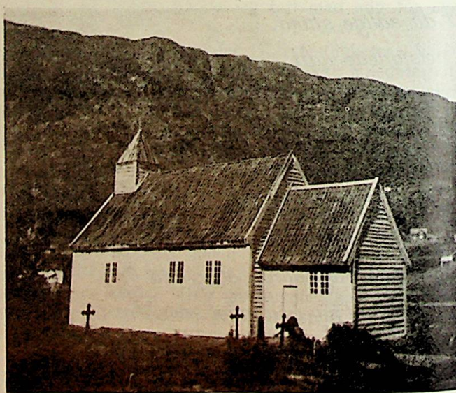
Røldal kirke før restaureringen.
