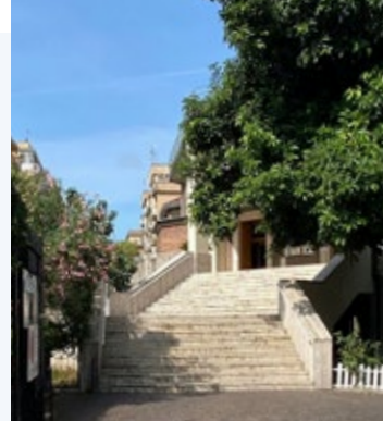
FIG. 2. Travertintrappen opp til inngangen
