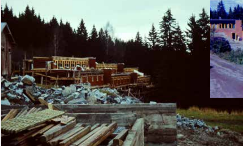
ARBEIDET ER IGANG: Byggearbeidene på Mariaholm ble påbegynt den 1. september 1966.
