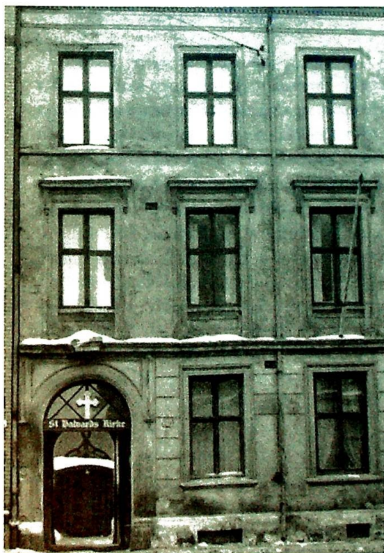
Den gamle prestegården – med porten inn til «bakgårdskirken» – i Urtegangen; her bodde fransiskanerne inntil de flyttet til Enerhaugen i 1967. I første etasje var det de seneste årene vaktmesterbolig, i annen etasje menighetslokale, kjøkken og kontorer; prestene bodde i tredje etasje. Illustrasjon fra Johs. Bruces bok «Fra Urtegangen til Enerhaugen» (1990).
