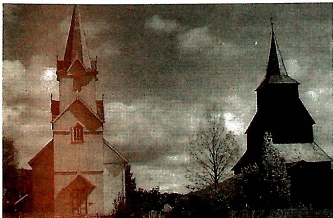
Gammelt og nytt i Hallingdal: restene av den gamle stavkirke og dagens sognekirke.
